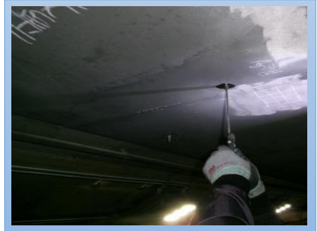
탄산화 깊이 측정 전경
