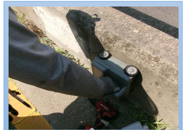
철근탐사 시험 전경
